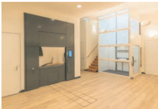
Een elektrische oven in een crematorium. (Foto: Daniël Niessen).
